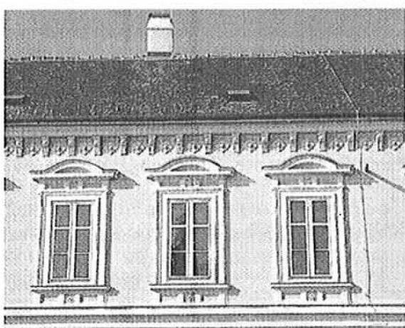
*Fig.6.Ornamente din polistiren șpacluit pe sistem termoizolant Baumit.*
